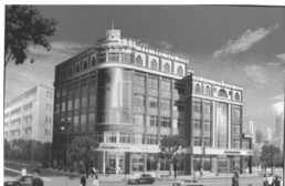
社保职介中心综合业务楼工程
