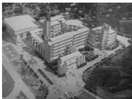
四团中学教学楼工程
