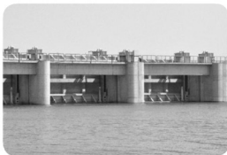
混凝土青草沙水库
