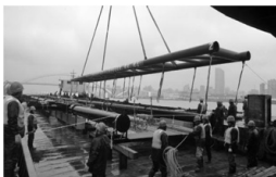
世博音乐喷泉吊装
