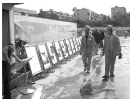
十三号线长青路站项目注重文明施工宣传
